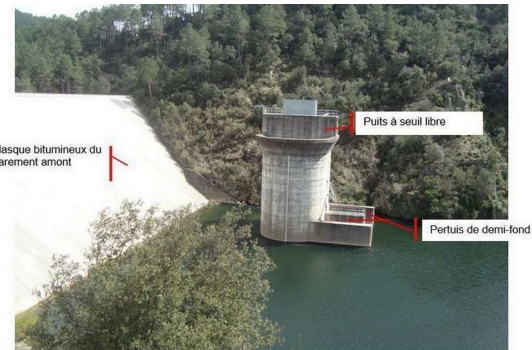
Figure n°3 : principaux organes du barrage
