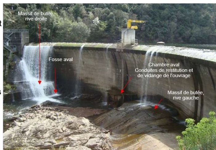
Figure n°8 : principales interventions sur le barrage
